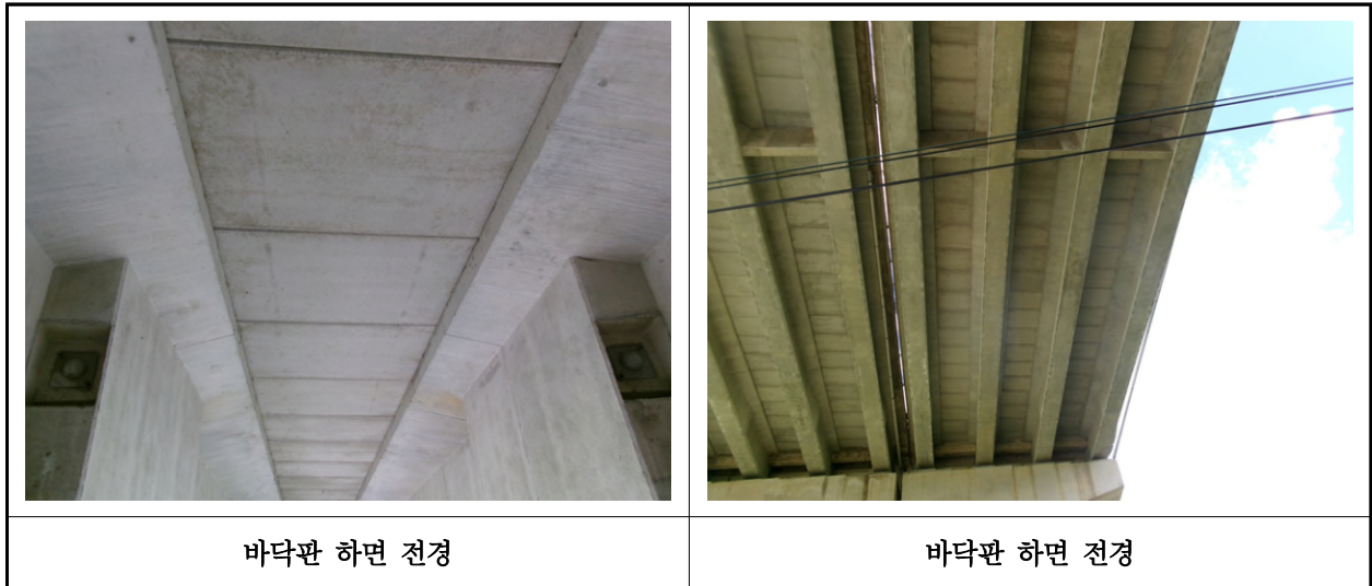
【사진 12.3.2】 바닥판하면 전경
