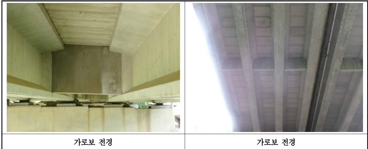
【사진 12.3.6】 가로보 전경
