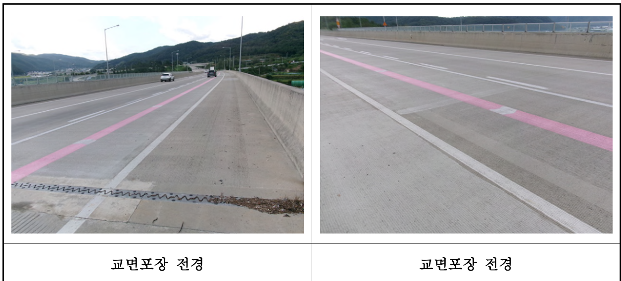
【사진 12.3.42】 교면포장 전경
