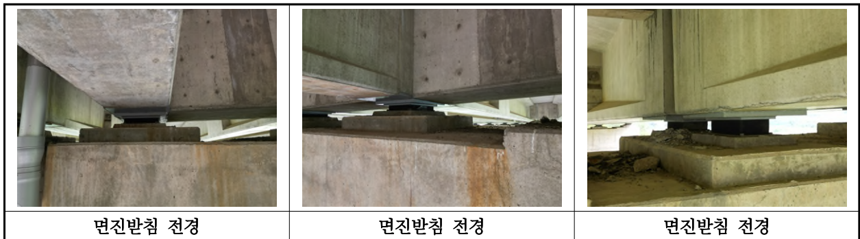
【사진 12.3.35】 교량반침 전경
