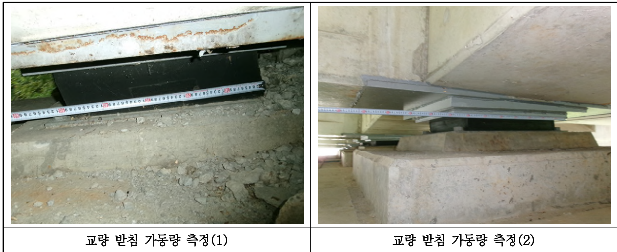
【사진 12.3.38】 교량받침 이동량 측정
