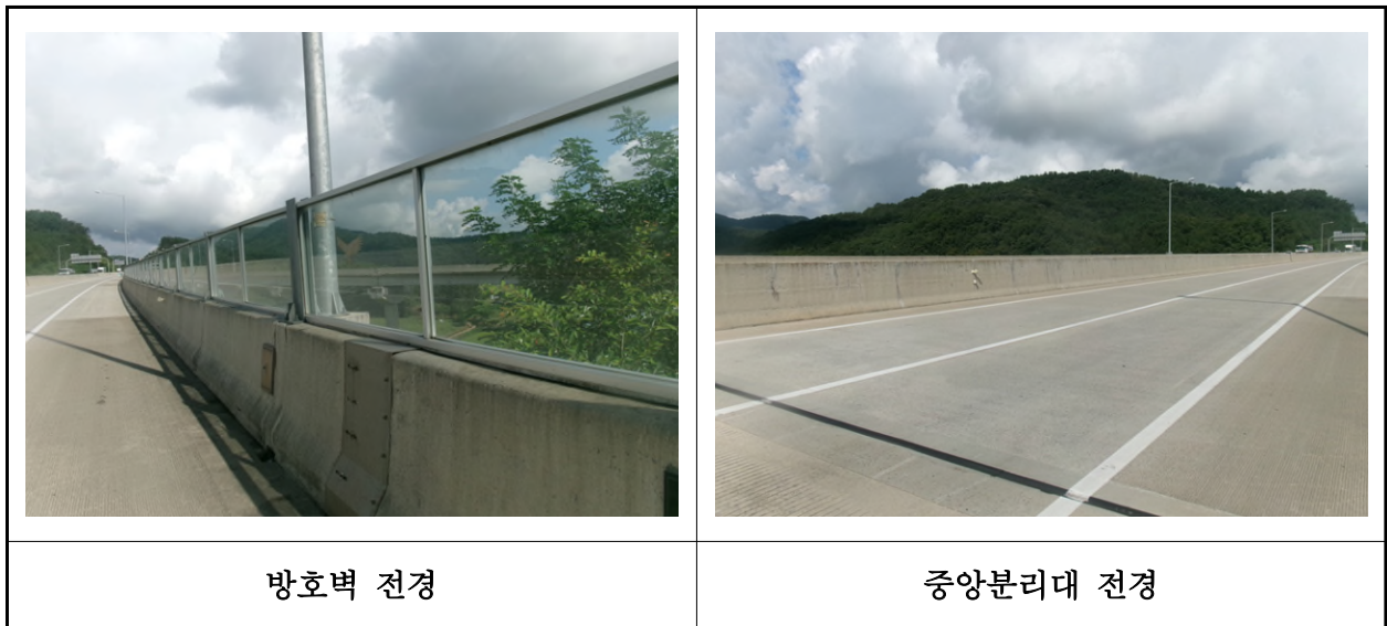
【사진 12.3.23】 방호벽 및 중앙분리대 전경
