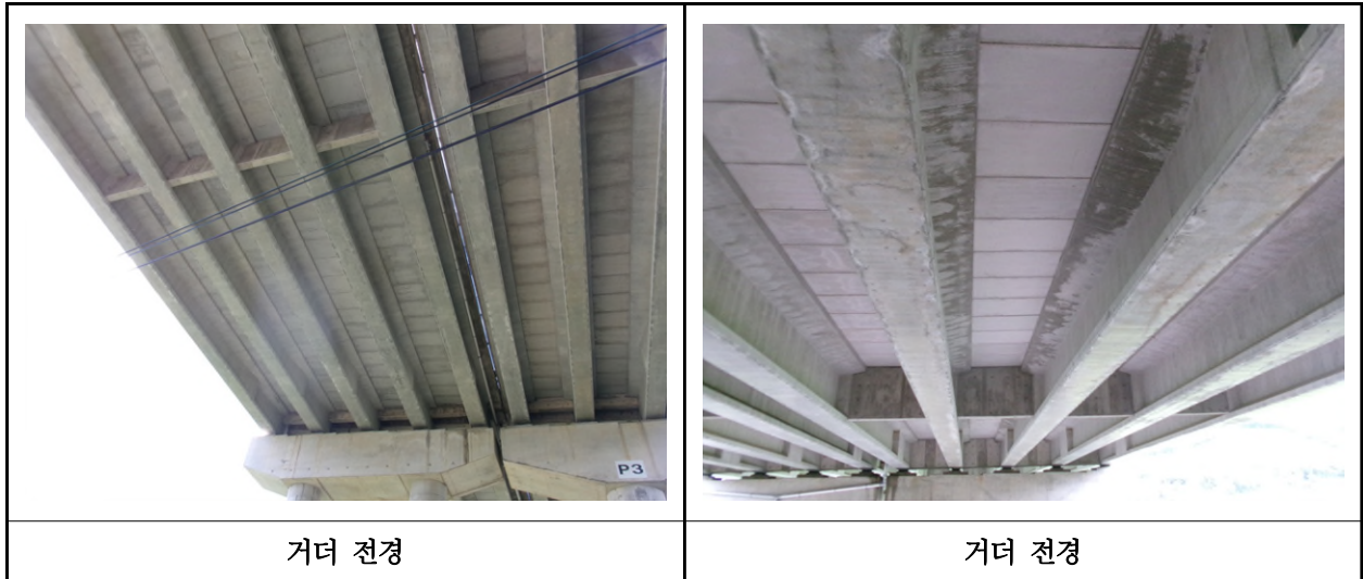
【사진 12.3.27】 거더 전경
