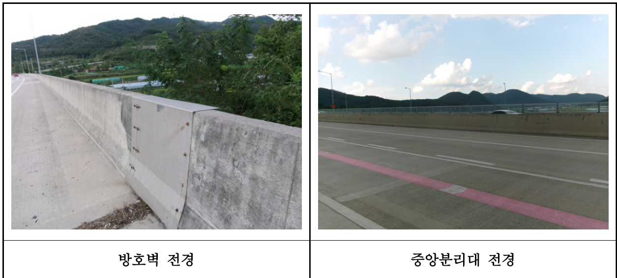
【사진 12.3.46】 방호벽 및 중앙분리대 전경
