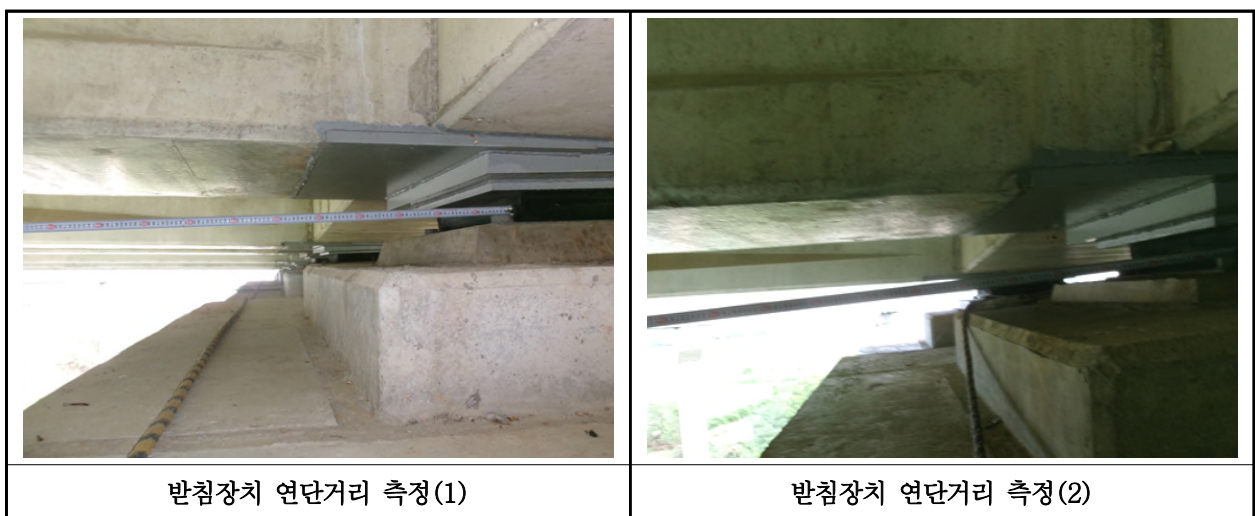
【사진 12.3.37】 교량받침장치 연단거리측정
