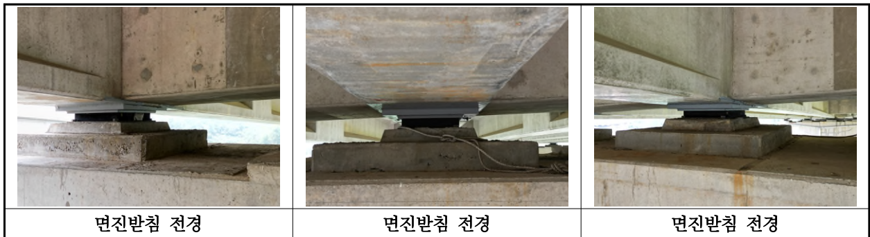
【사진 12.3.12】 교량받침 전경
