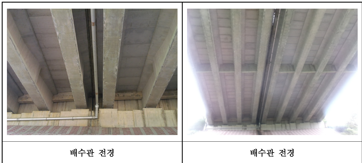
【사진 12.3.44】 배수시설 전경
