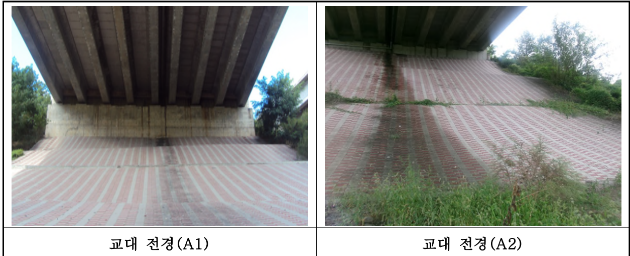
【사진 12.3.31】 교대 전경
