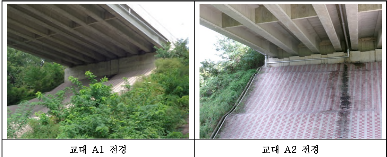
【사진 12.3.8】 교대 전경
