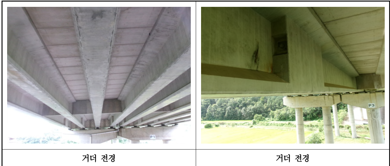
【사진 12.3.4】 거더 전경
